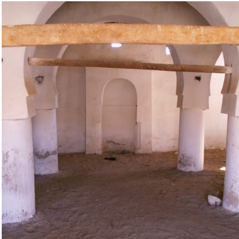
Mosquée Maamra de l'intérieur
